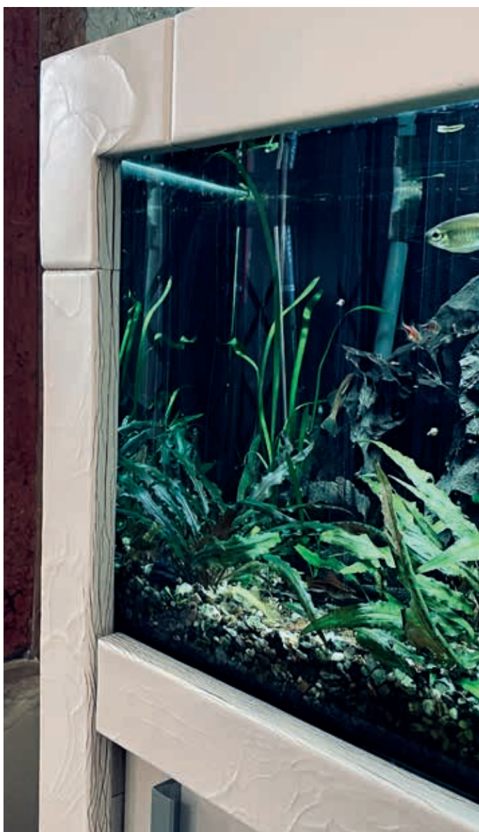
Nedostatečné odizolování dřeva od přímého styku s vodou
