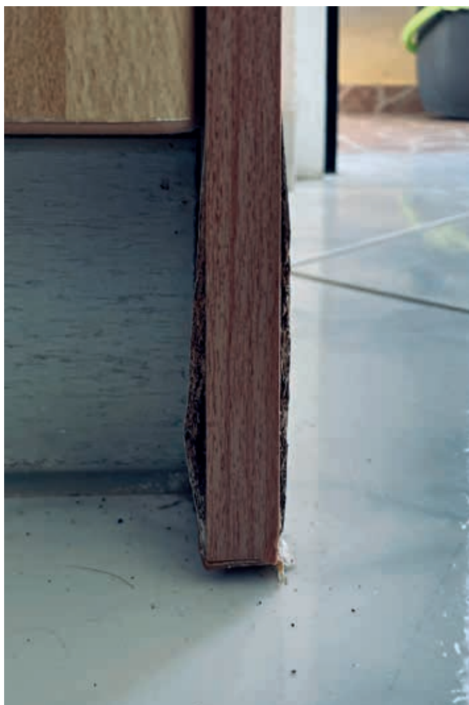
Bočnice kuchyňské linky ve styku s podlahou. Důsledek vlivu vlhkosti
