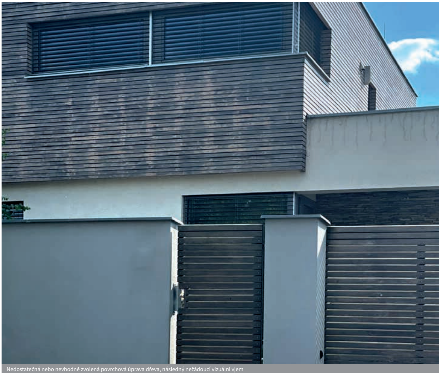
Nedostatečná nebo nevhodně zvolená povrchová úprava dřeva, následný nežádoucí vizuální vjem
